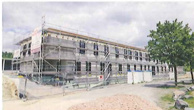
Blick vom Gelände des TRIO's auf den fertiggestellten Rohbau der Polizeistation
