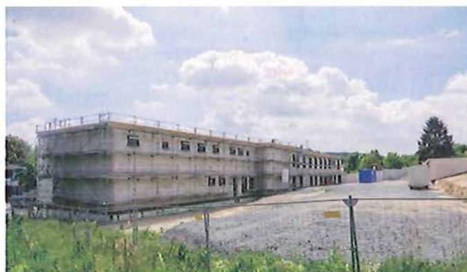
Blick auf die Rückseite des Neubaus. Stand 20. Mai 2020.
