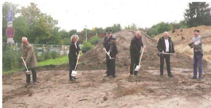
Am 27. September fand der gemeinsame Spatenstich für die neue Polizeistation statt (Foto: Stadt Ober-Ramstadt).
