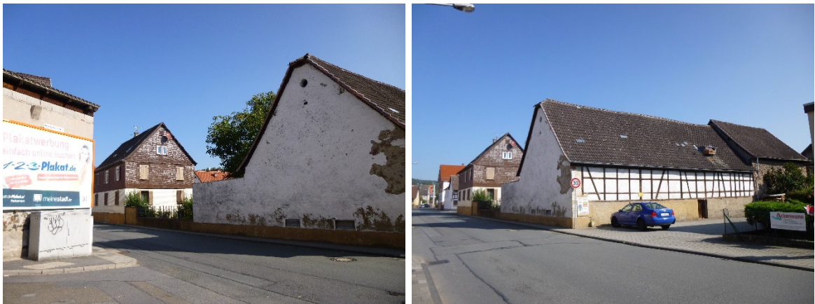
Abbildung 8: Straßenfront und Scheunengebäude Odenwaldstraße
