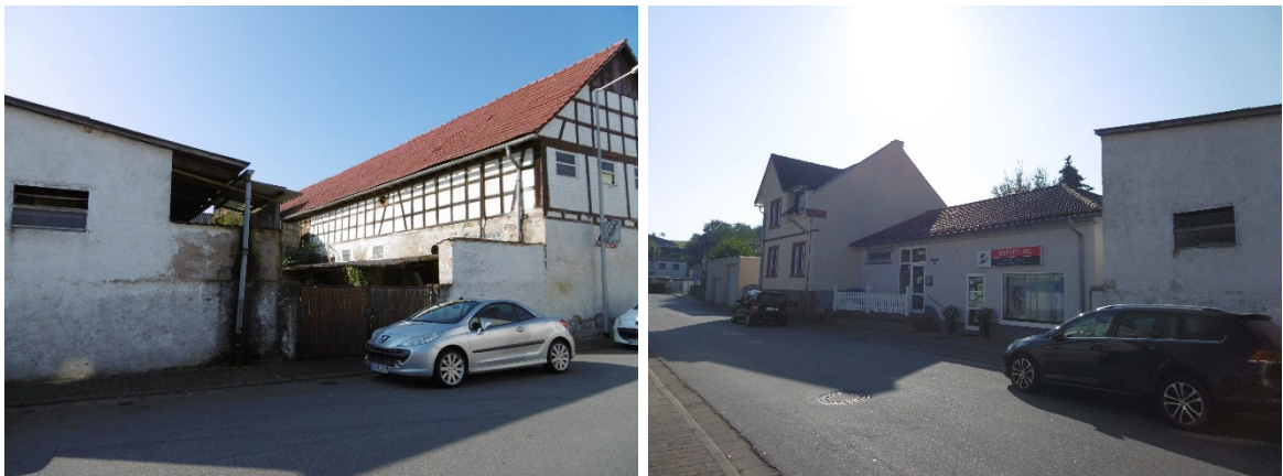
Abbildung 9: Scheunengebäude Kirchstraße und Haus Kirchstraße 5
