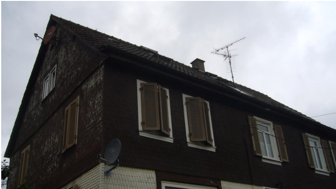
Foto 3 Wohnhaus mit Schindeln und Fensterläden – Sanierung geplant
