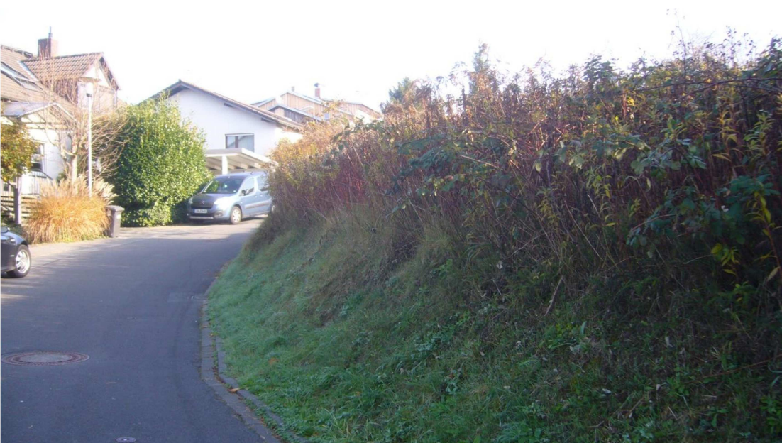
Foto 4: Böschung an der Weberstraße
