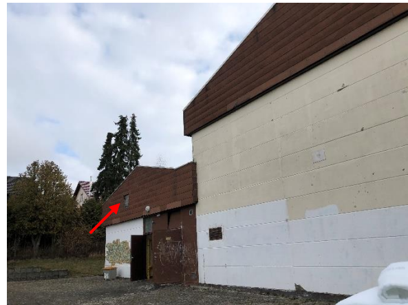
Abb. 8: Einstieg in den Dachstuhl von außen über Luken (roter Pfeil)
