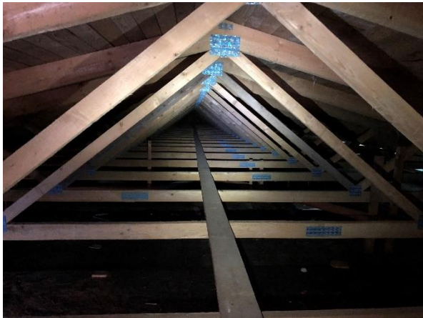
Abb. 9: Holzkonstruktion im Dachstuhl
