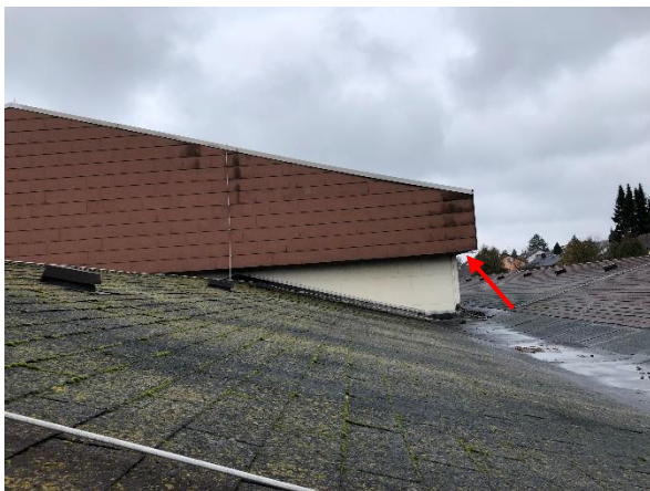
Abb. 11: Dachbereich mit Dachüberstand (roter Pfeil)
