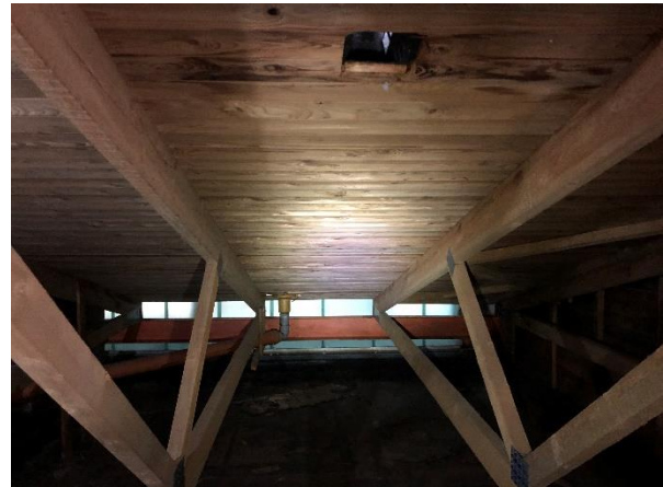
Abb. 10: Holzkonstruktion im Dachstuhl
